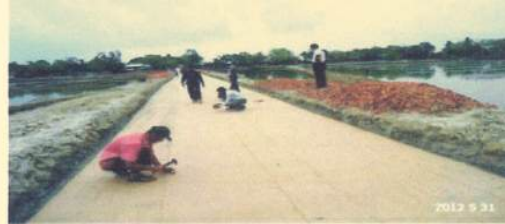
Fig: Laying of JGT
