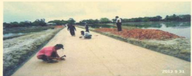
Fig: Laying of JGT
