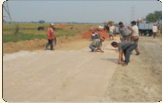
JGT laid over sand layer
